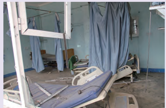
▲砲撃の被害を受けた病院（イエメン）© ICRC
