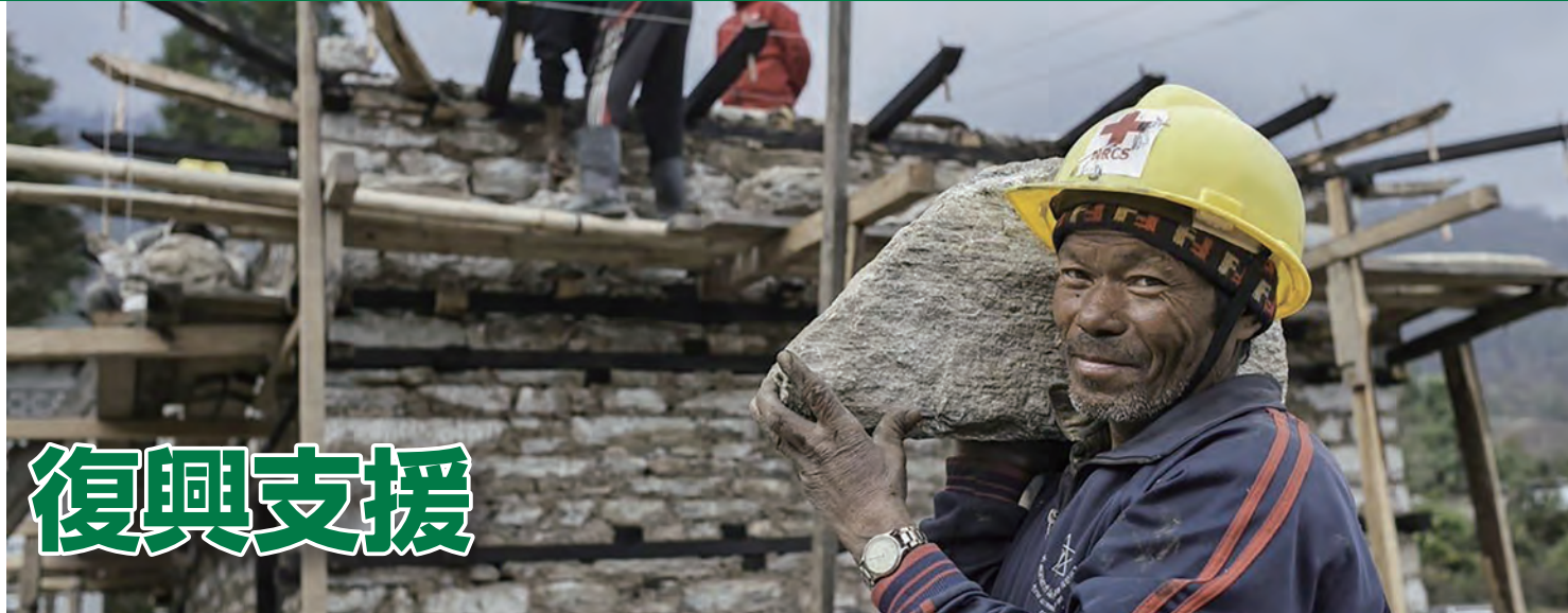
▲地震に強い住宅を建設する地元の大工（ネパール）© IFRC
